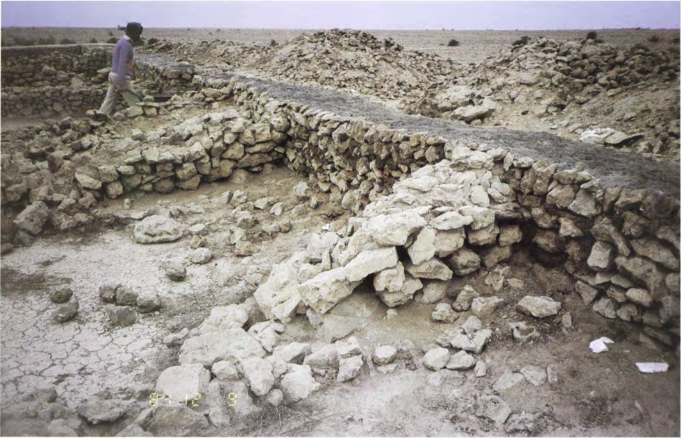
مروب - الجدار الشمالي للقلعة من الداخل أثناء عملية الترميم .
